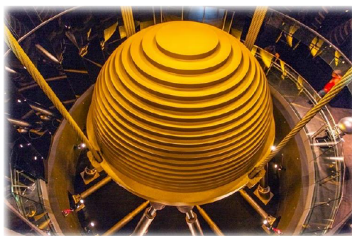
Σχήμα 3.13: Αποσβεστήρας μάζας.
